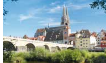
Steinerne Brücke in Regensburg
